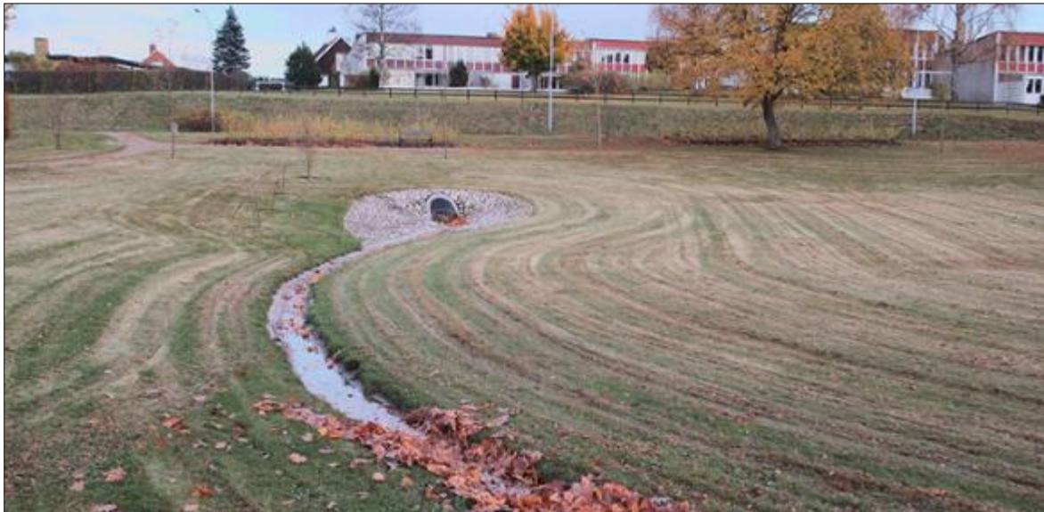
Figur 21. Exempelbild över en torrdamm med möjlighet för temporärt stående vattenyta (SVOA, 2022).
