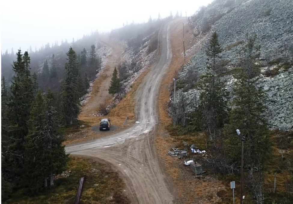
Figur 10. Drönbild mot väst och över nedfarten som planernas utvidgas samt den övre nedfarten som ska utgöra liftens väg.
