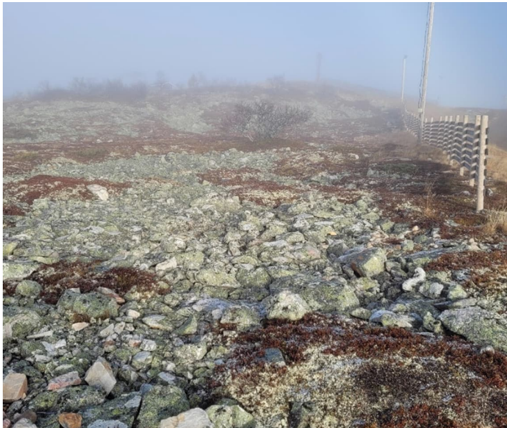
Figur 20. Området för liftens toppstation är relativt platt och blockrik.
