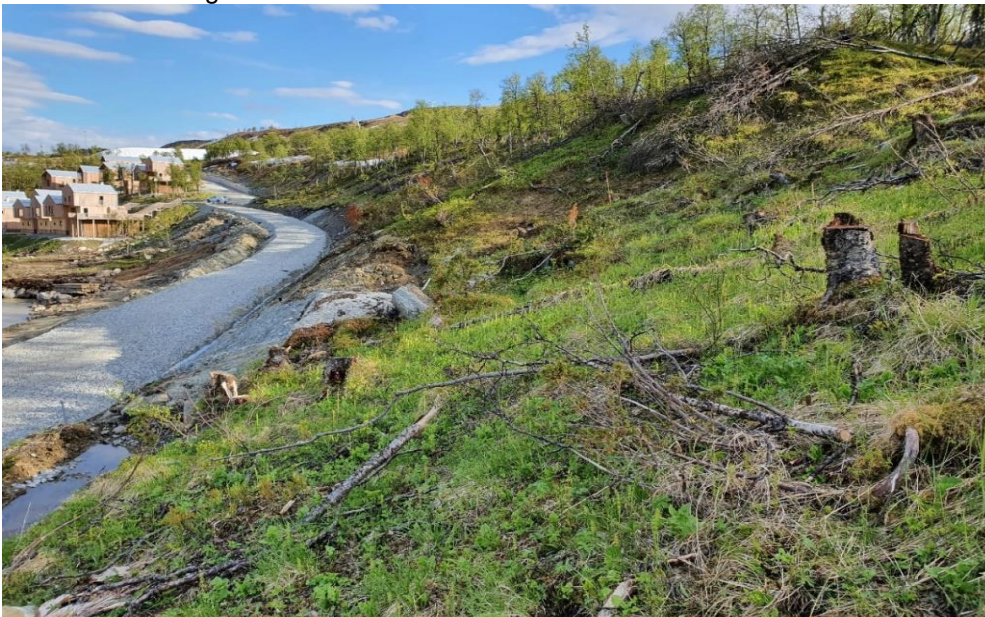
Figur 6. Brant slänt mot öst. Bebyggelse har utförts i kring släntens fot.
