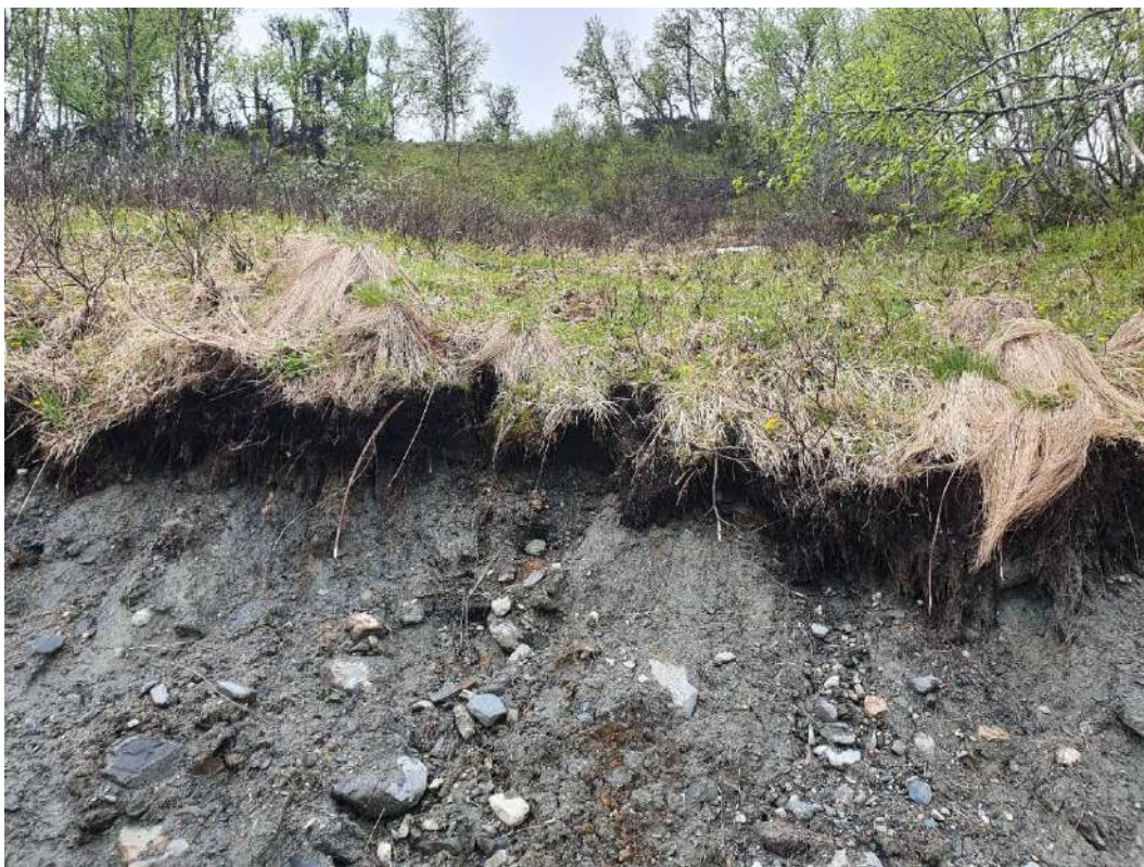
Figur 9. Brant slänt där skred har förekommit i schaktning för mindre väg. Siltmorän går att se i schakten.
