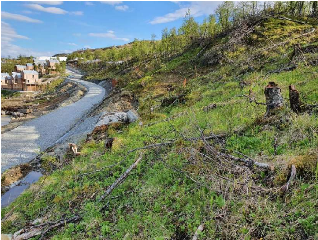
Figur 4. Brant slänt mot öst, stor skredrisk kan antas.
